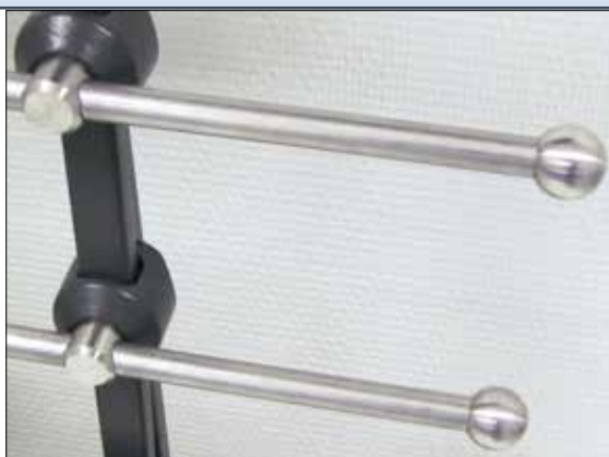
Détail des brides de fixation des lisses inox.
