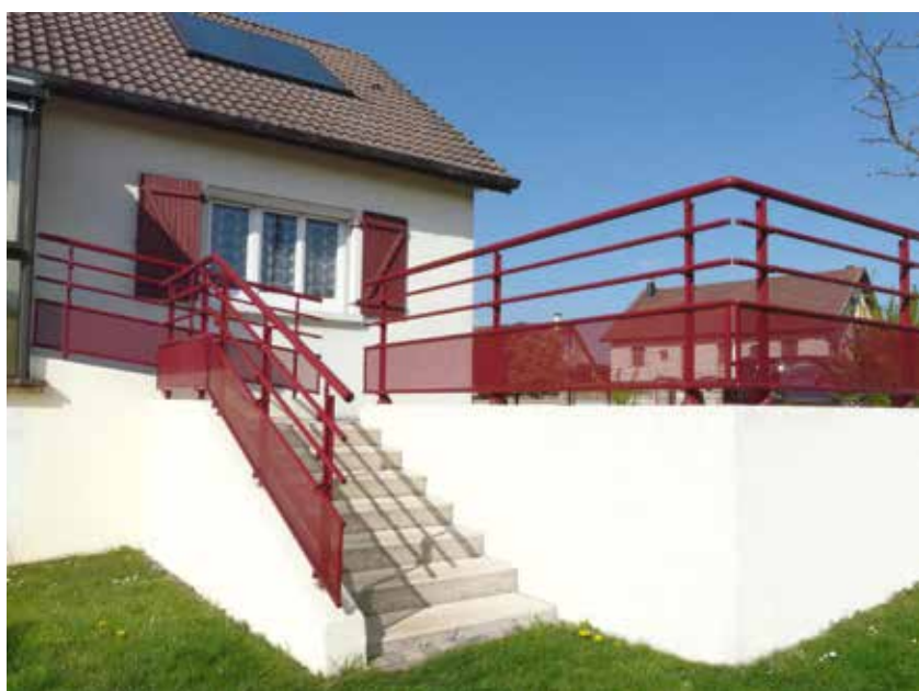
Athys avec double lisse intermédiaire et remplissage en tôle alu perforée
