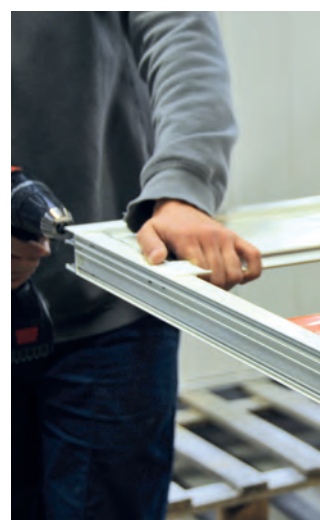
PRÉMONTAGE EN ATELIER pour une pose rapide
